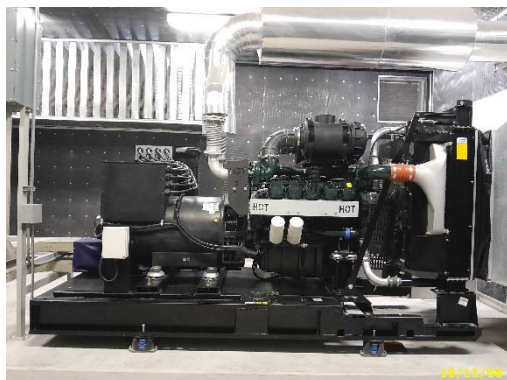
ภาพที่ 2.2-7 ระบบกรอง Scrubber Filter ห้องเครื่องกำเนิดไฟฟ้า
