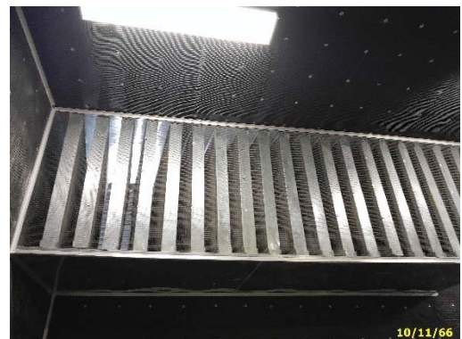
ภาพที่ 2.2-7 ระบบกรอง Scrubber Filter ห้องเครื่องกำเนิดไฟฟ้า
