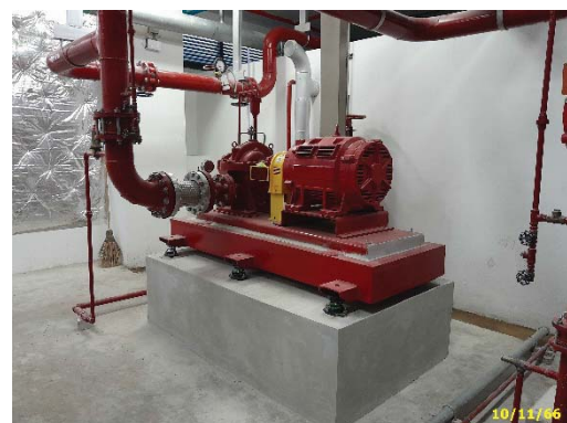
เครื่องสูบน้ำดับเพลิง ชั้น 23 อาคาร X
